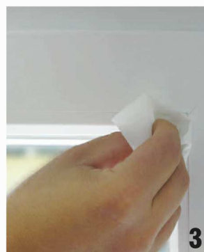
Abb. 2, 3: Mit dem Reini- gungstuch die zu verklebenden Flächen am Fen- sterflügel säu- bern (seitlich und oben die Glasleistendeck- flächen)
