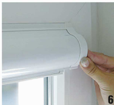
Abb. 6: Kassette vorsich- tig andrücken und waagrecht ausrichten.
