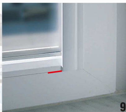
Abb. 8, 9: linkes und rechtes Abdeckprofil (ausgestanzte Seite ist oben) vorsichtig unter die Kassette bündig anschieben bis untere Höhe ( Abb. 9 ) erreicht ist. Nun die Abdeckleiste fest andrücken.
