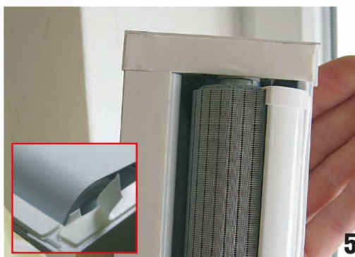
Abb. 4, 5: An der Halbkas- sette (rückseitig) die Folie vom Klebe- band abziehen.
