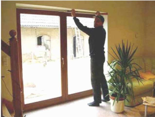
Abb. 1: Aufmass der lichten Breite in der Laibung
